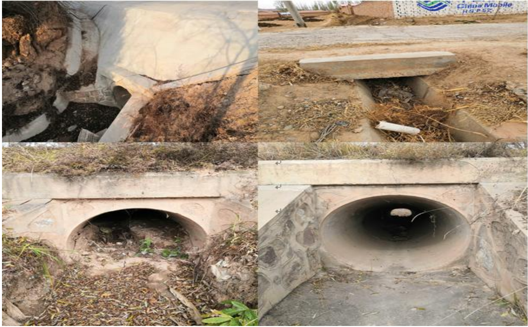
旧路涵洞概貌
