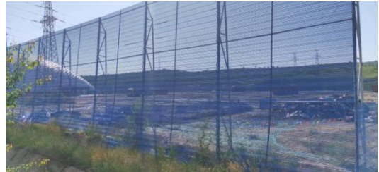
选煤厂气膜棚西侧场地
